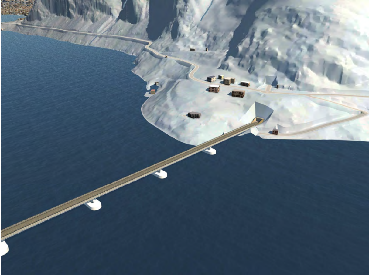
Figur 5-1 Alternativ 1A - Låg bru med landtilknytning til lang tunnel på Greifsneset
